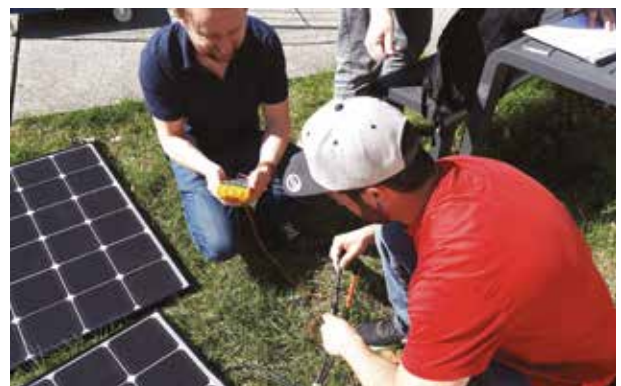
Die Anlage wurde auf dem Dach des Gebäudes Achstraße installiert und in Betrieb genommen.
